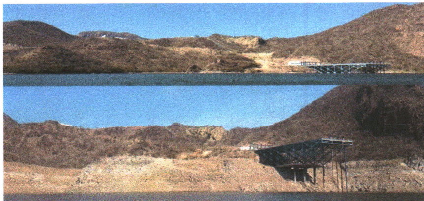
Figura 11. Vista a la plataforma de Obra de toma del Acueducto Independencia en los años de almacenamiento ordinario (arriba) y 2021 (abajo).
